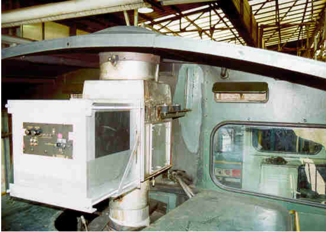
Fig. 4: EM connected to the D.245 exhaust pipe.
