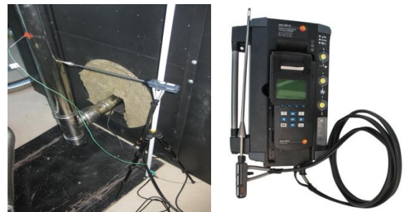
Figura 4: Sezione di misura dei fumi (sinistra), analizzatore fumi Testo 350 (destra)
